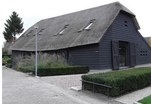
Deze eeuwenoude schuur is in 2012 geheel gerestaureerd. De gevels zijn “gepotdekseld”.
